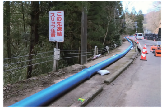
輪島市 配水管復旧
