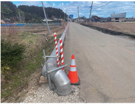
珠洲市 送水管復旧
